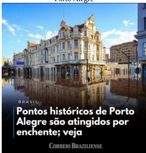
Imagem 6 – Edifício Ely (tombado como patrimônio cultural municipal) no entorno da Rodoviária de Porto Alegre
