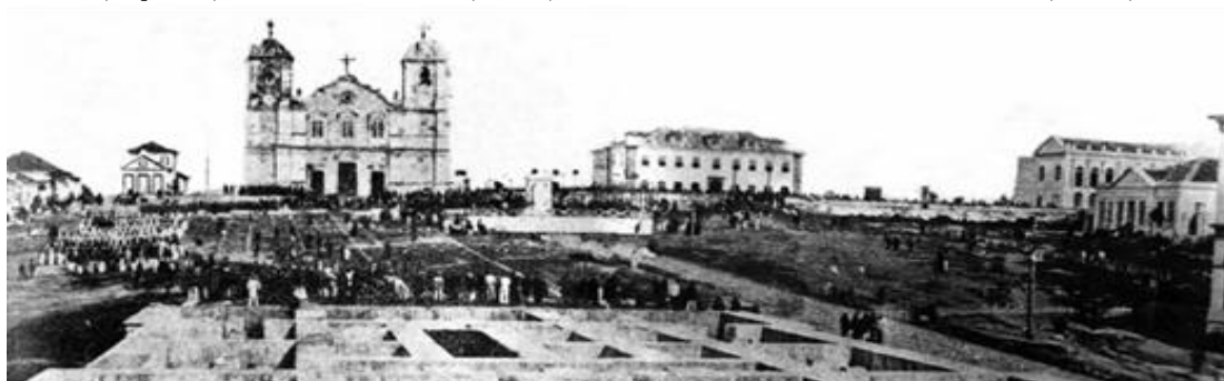
Imagem 30 - Praça da Matriz tendo ao fundo a Igreja da Matriz com a Capela do Divino Espírito Santo (esquerda), o Palácio de Barro (centro) e a sede da Provedoria da Real Fazenda (direita)
