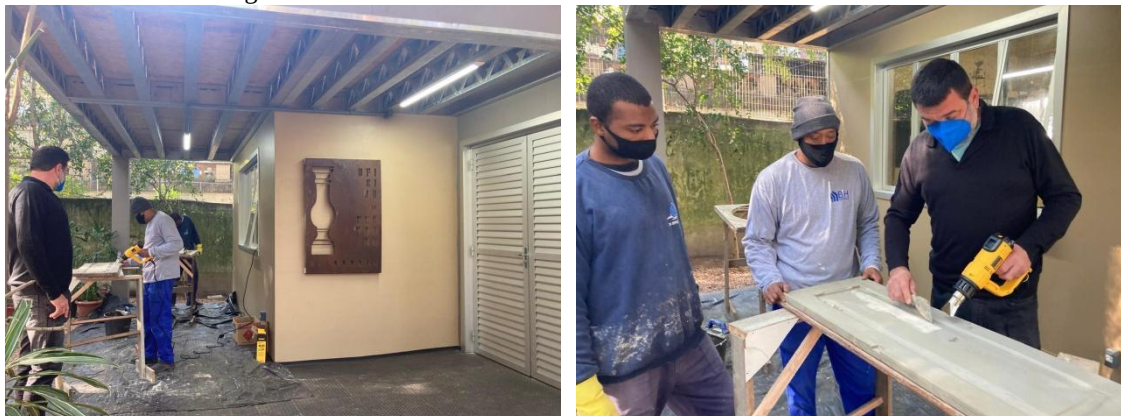
Imagens 110 e 111 – Restauro de aberturas históricas do Palácio Piratini.
