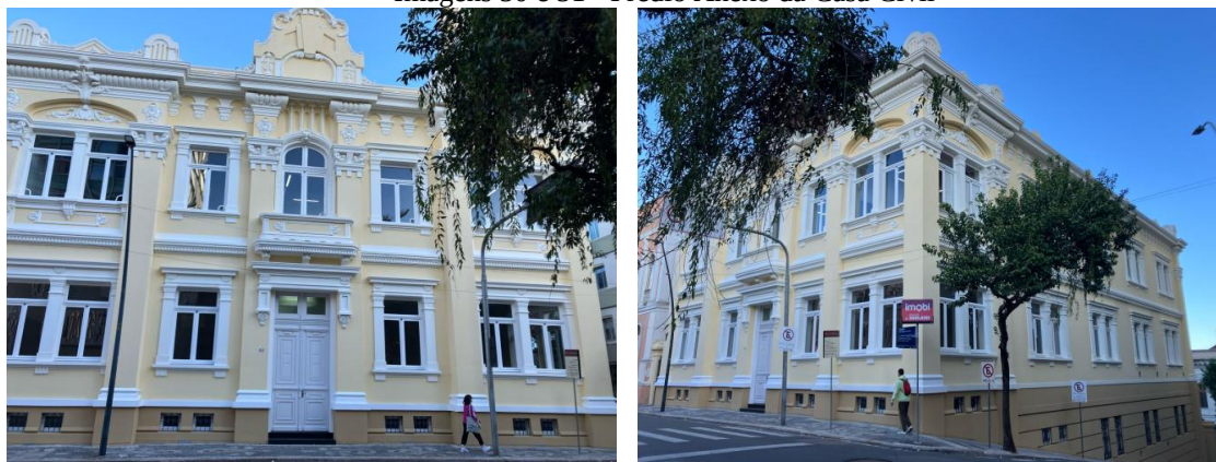
Imagens 50 e 51 - Prédio Anexo da Casa Civil
