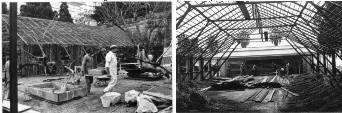
Imagens 96 e 97 - Construção do Galpão Crioulo
