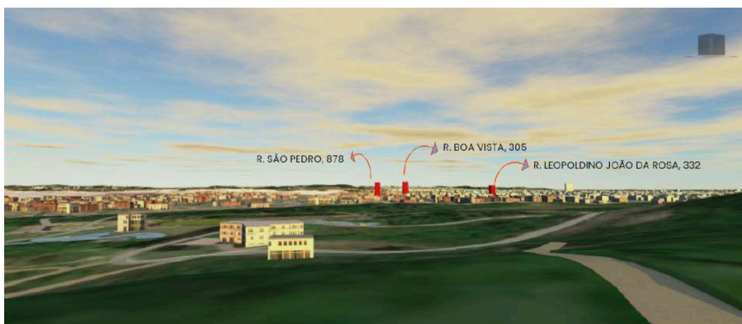
Figura 27 - Prédios em execução na Área 2 Fonte: Desenvolvido pela Equipe - Junho 2026
