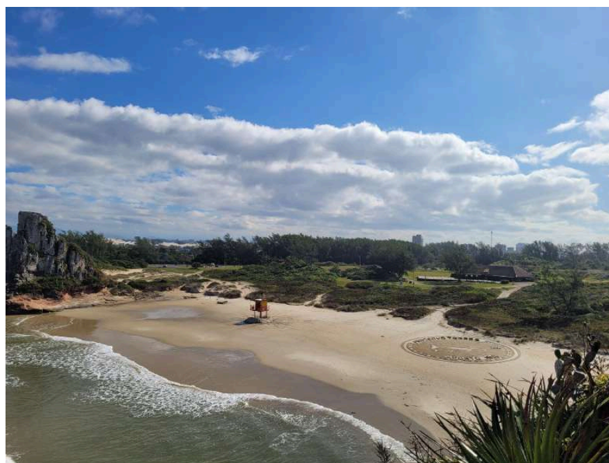
Figura 15 - Vista da Torre do Meio - Morro das Furnas Fonte: Foto Equipe Iphae - 03/06/2026
