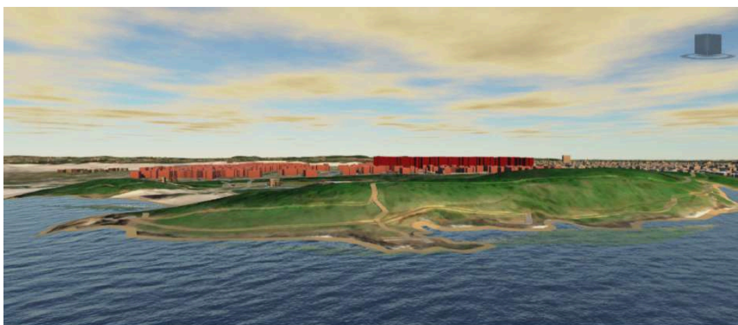
Figura 41 - Vista aérea a partir do mar - Área 1 com 15m de altura e Área 2 com 40m de altura.
