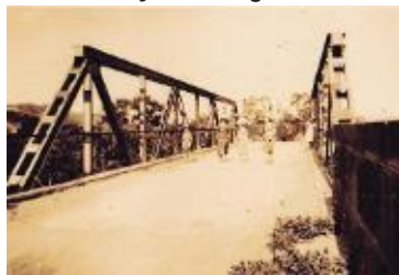
Fotografia da ponte de ferro sobre o rio Cadeia. Sem datação. Versão digital disponibilizada no blog Histórias do Vale do Caí.
